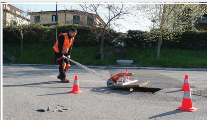
Il **sistema Hook** estende la possibilità di apertura dei sistemi di sollevamento Valifter, permettendo ad essi l'ancoraggio meccanico sui chiusini.
